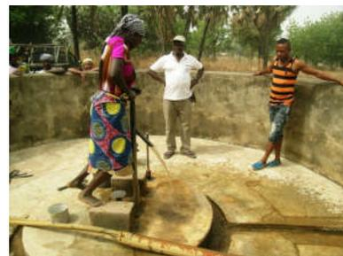
pedale con tubi di plastica o materiali affini, e vanno bene soprattutto per il Sahel perchè arrivano fino a 150 metri di profondità.
