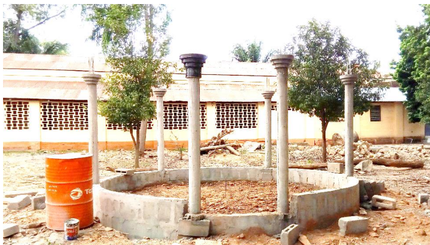
Construction d'une paillote qui fera office de salle d'attente des paroissiens
